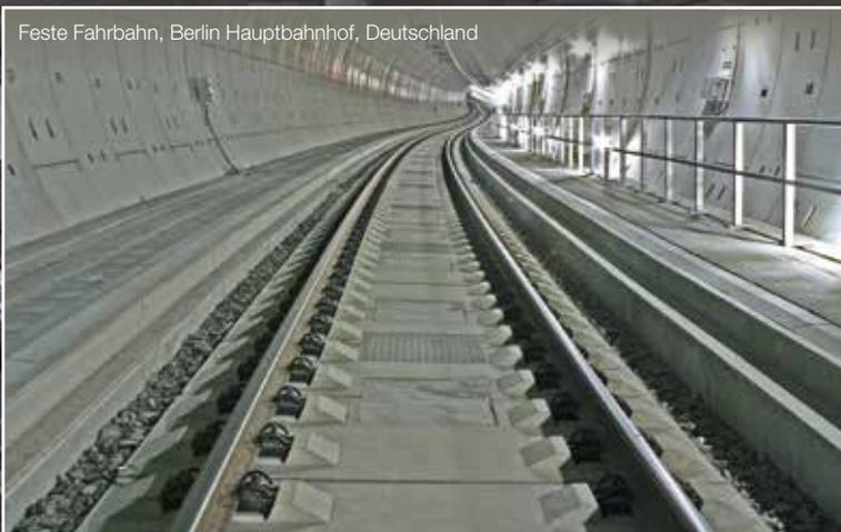
In Zusammenarbeit mit den Österreichischen Bundesbahnen (ÖBB) entwickelte die PORR das Feste-Fahrbahnssystem – Slab Track Austria „elastisch gelagerte Gleistragplatte ÖBB-PORR“. Es zeichnet sich dadurch aus, dass die hohe Präzision der Gleistragplatte eine exakte Gleisanlage mit hervorragenden dynamischen und körperschalltechnischen Eigenschaften gewährleistet.
